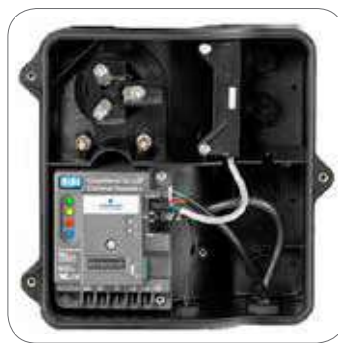
Система диагностики CoreSense™ для холодильных спиральных компрессоров
